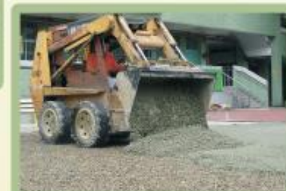
2. 透水混凝土澆注
