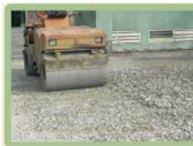
1. 路基夯實整平
