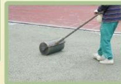
4. 透水混凝土壓實
