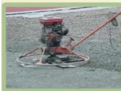
3. 透水混凝土整平
